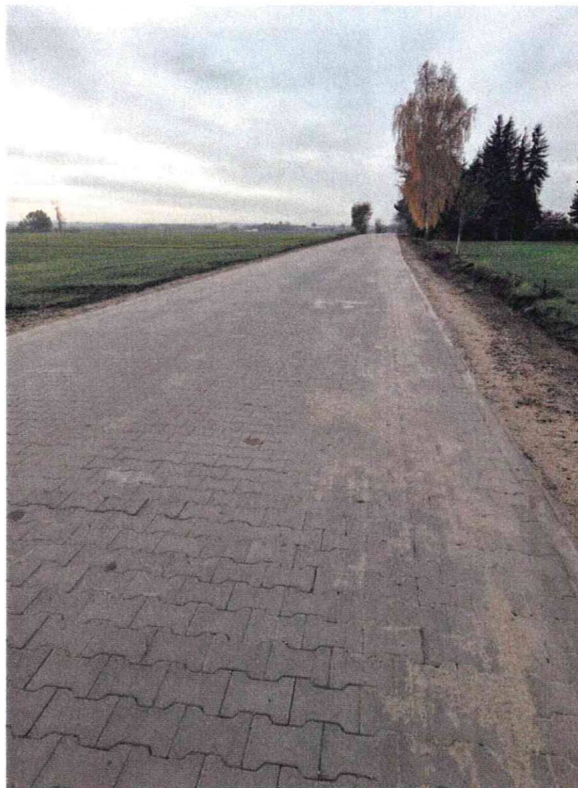
Fot. Droga gminna w m. Głuchowo.
