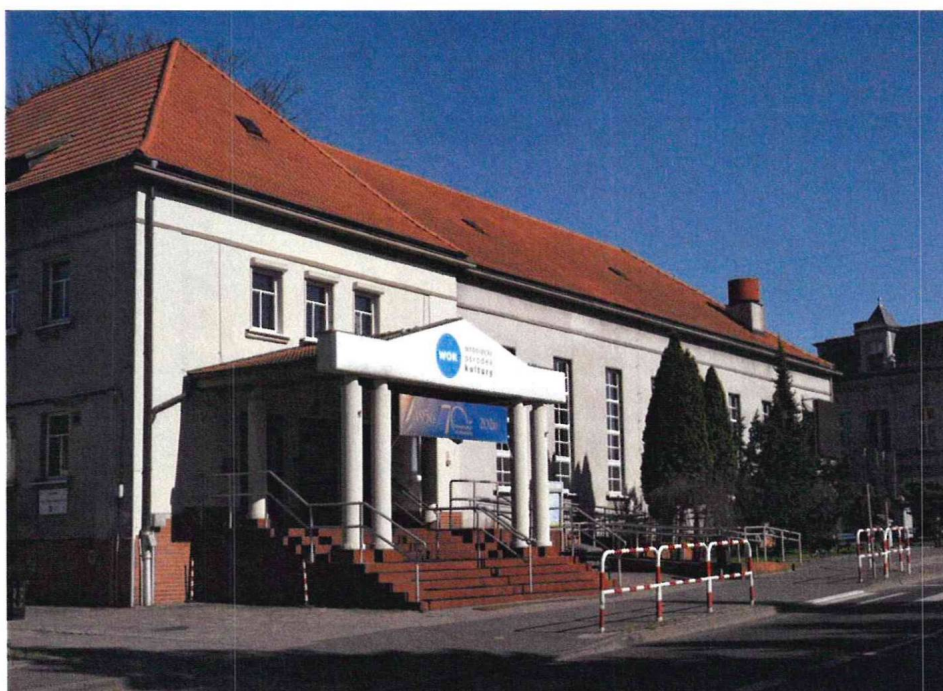
Fot. Budynek Wronieckiego Ośrodka Kultury we Wronkach.
