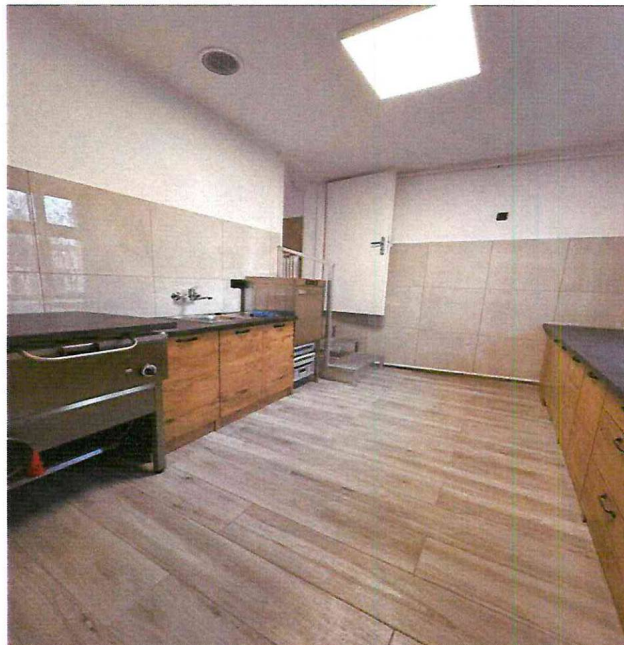
Fot. Remont kuchni w świetlicy wiejskiej w m. Biedzrowo
