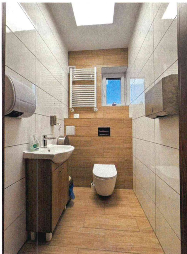
Fot. Remont toalet w świetlicy wiejskiej w m. Popowo
