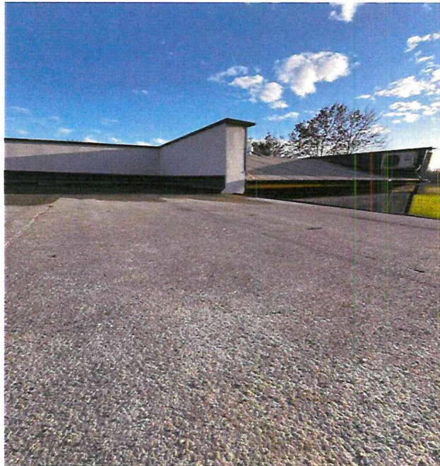
Fot. Remont dachu w świetlicy wiejskiej w m. Głuchowo
