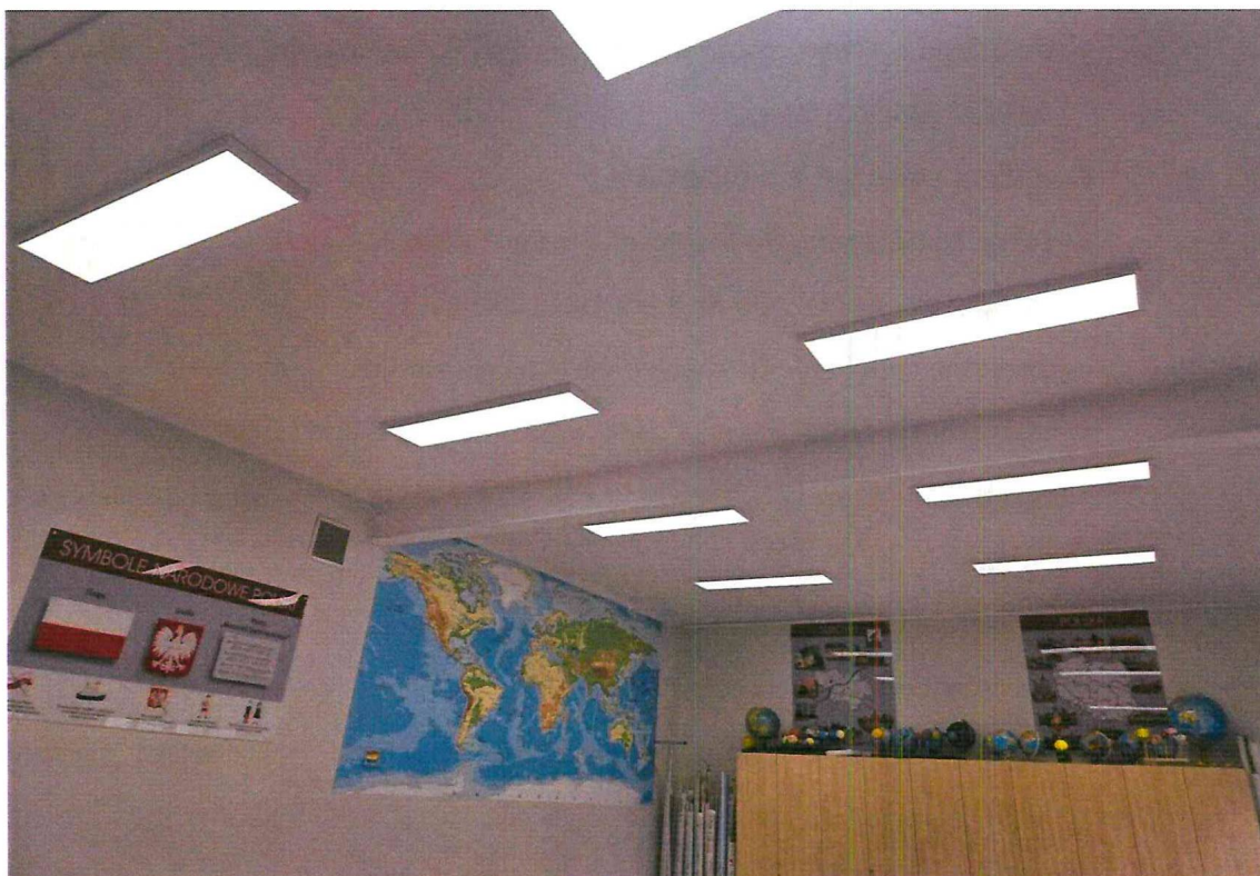
Fot. Nowe oświetlenie w Szkole Podstawowej nr 2 im. Kornela Makuszyńskiego we Wronkach
