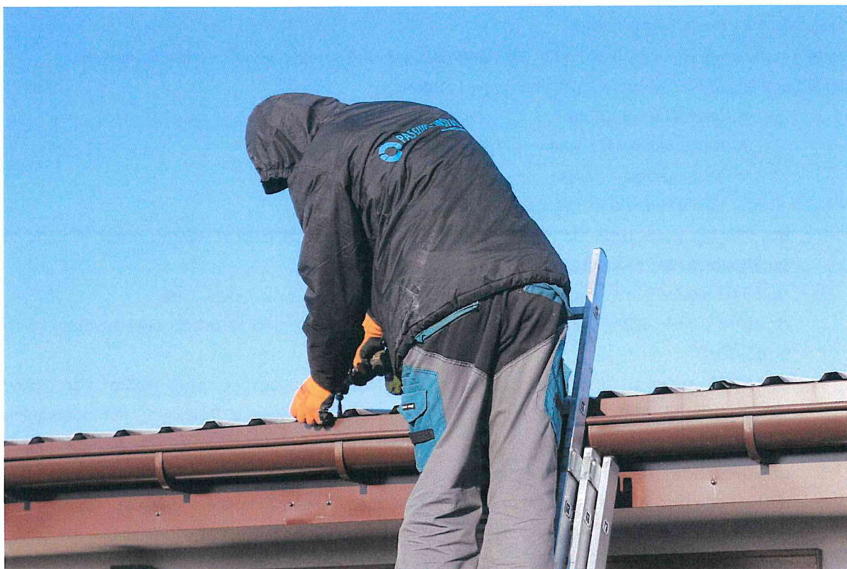
Fot. Montaż paneli fotowoltaicznych w Nowej Wsi
