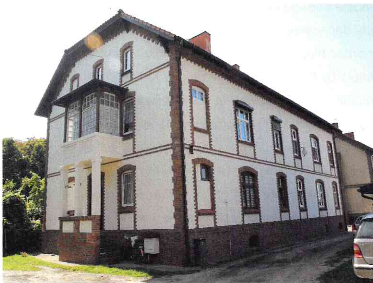
Fot. Kamienica przy ul. Dworcowej po remoncie
